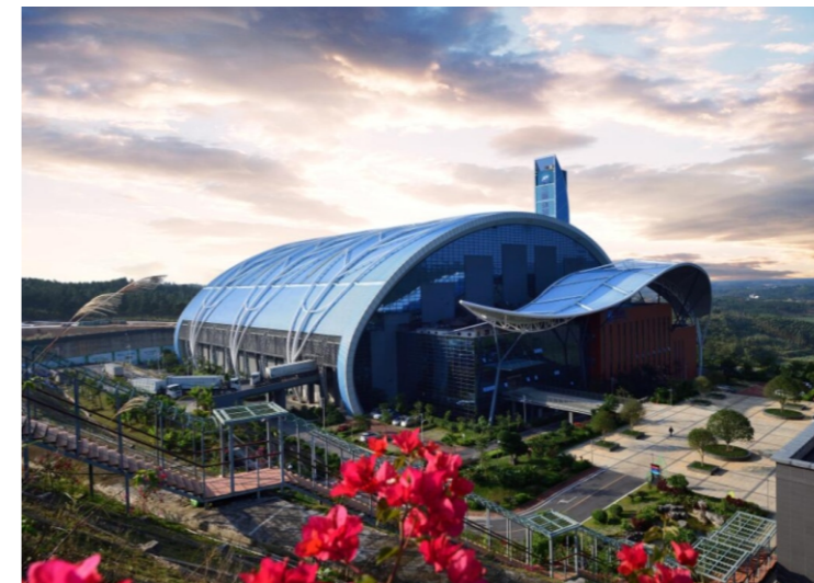
南宁三峰环保发电厂（2000吨/天）
