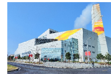
浙江绍兴环保发电厂（2250吨/天）
