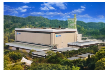
重庆丰盛环保发电厂（2400吨/天）
