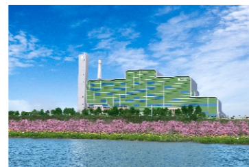
安徽六安环保发电厂（1200吨/天）
