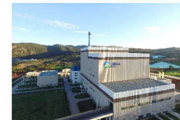
昆明三峰环保发电厂（1000吨/天）
