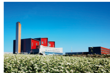
内蒙古赤峰环保发电厂（800吨/天）
