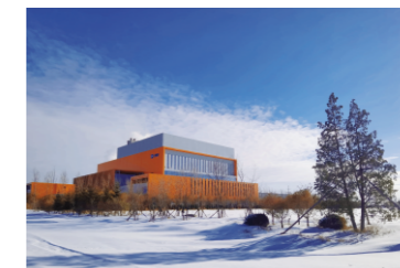
辽宁鞍山环保发电厂（1500吨/天）
