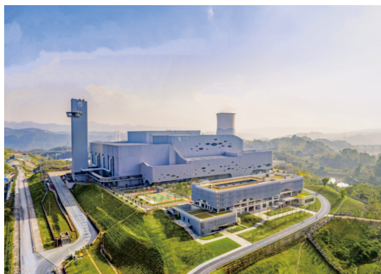
重庆御临环保发电厂（3000吨/天）
